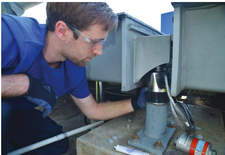
Die Umrüstungsbausätze erleichtern die Aufrüstung bestehender Fahrzeugwaagen.
